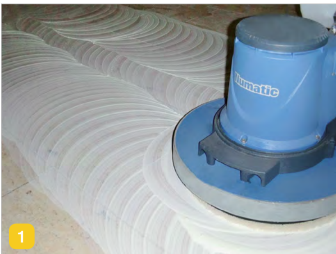
1 Einarbeitung des Kristallisationsmittels (linear zum Kreuzgang)
