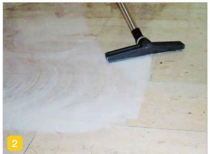
2 Absaugen der Kristallisationsschlämme
