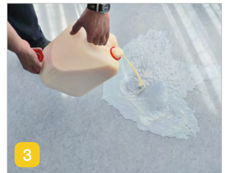
3 Auftragen der neuen Beschichtung
